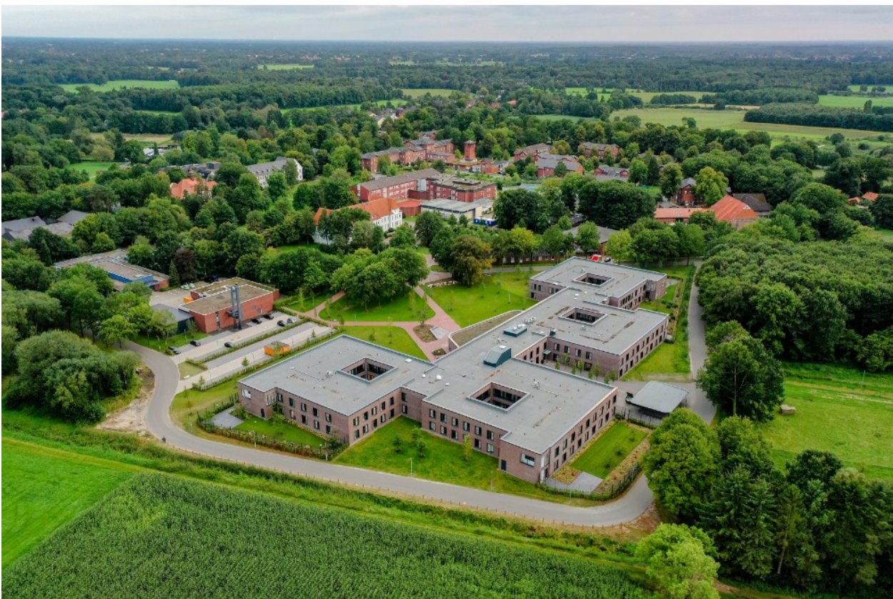
Das Gelände von oben
